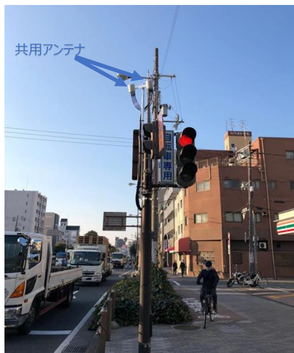
信号柱へ共用アンテナを設置(現在は撤去済)
